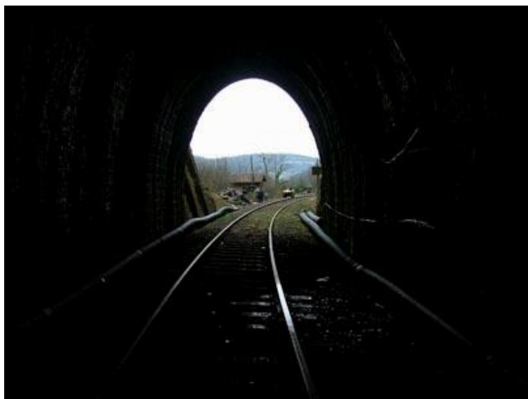
Et le tunnel dans son état ancien, tel qu'il apparaissait avant travaux
