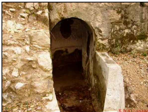
Débouché extérieur du drain principal
