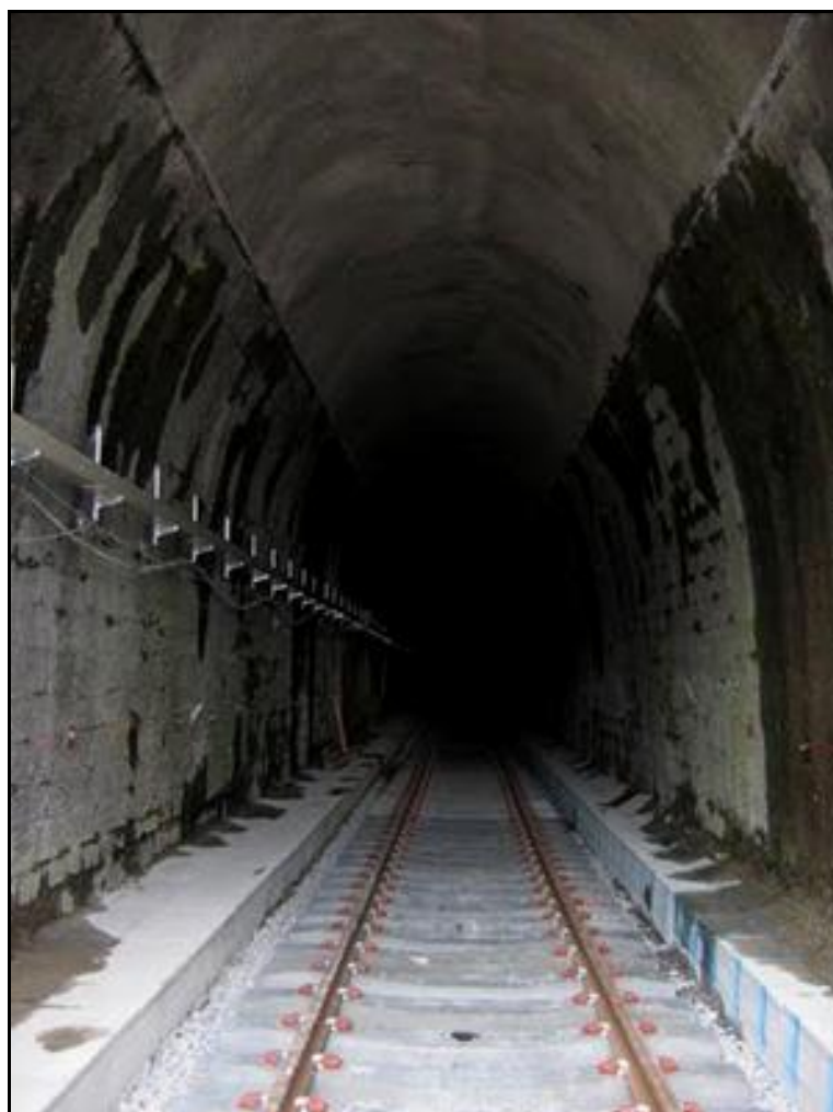
Ci-dessus, le tunnel dans son nouvel aspect actuel, après travaux
