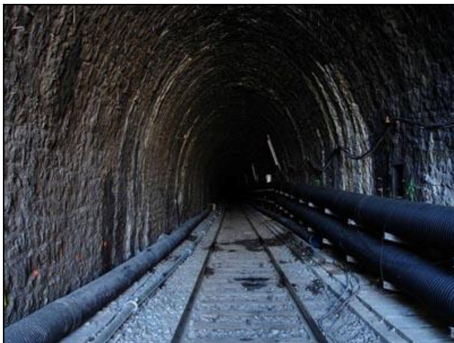
La galerie dans son état ancien mais avec les gaines d'aération temporaires en vue des travaux
