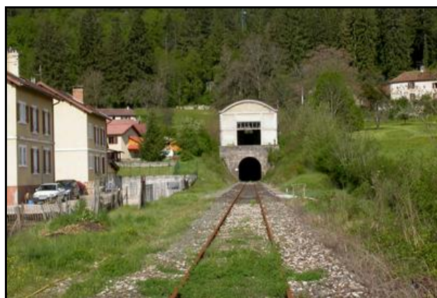
Les deux maisons à gauche ont été construites pour les employés qui devaient faire tourner l'usine d'aération
