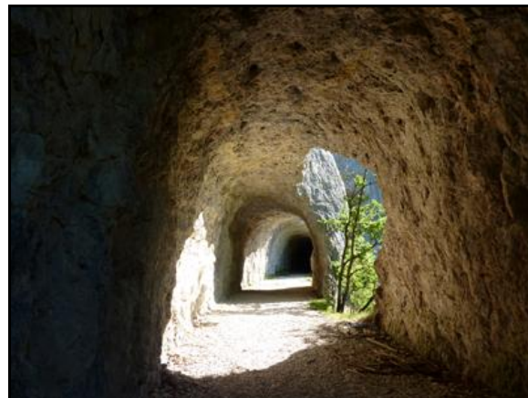
La sortie vue depuis le tunnel des Cascades 1 Tout au fond, la sortie du tunnel des Cascades 3
