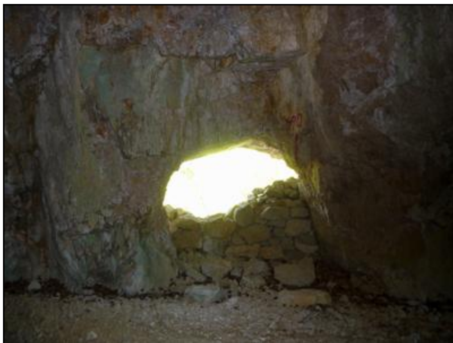
La fenêtre proche de la sortie, dans le piédroit gauche
