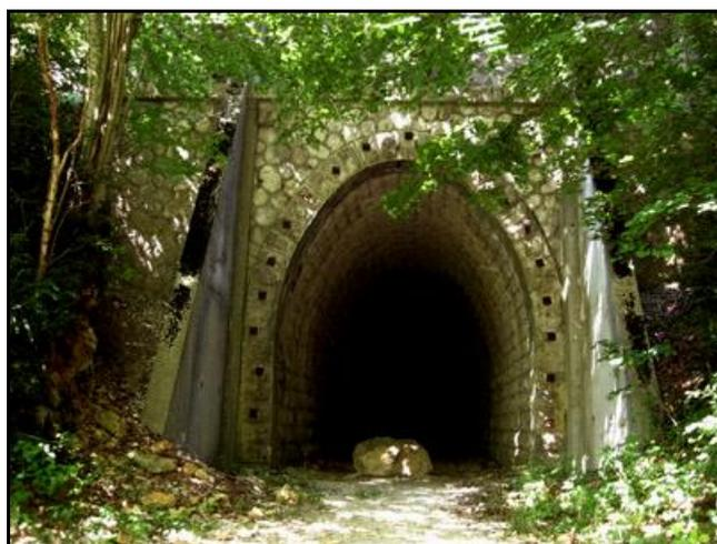
Les têtes des tirants d'ancrage et les contreforts béton sont ici bien visibles
