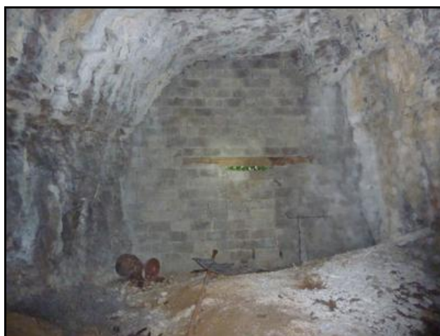
La sortie murée vue de l'intérieur
