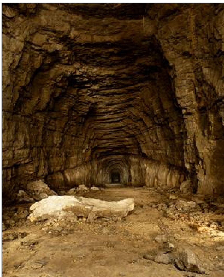
Effet d'optique : le tunnel est plat ; ce sont les couches de terrain qui sont déversées
