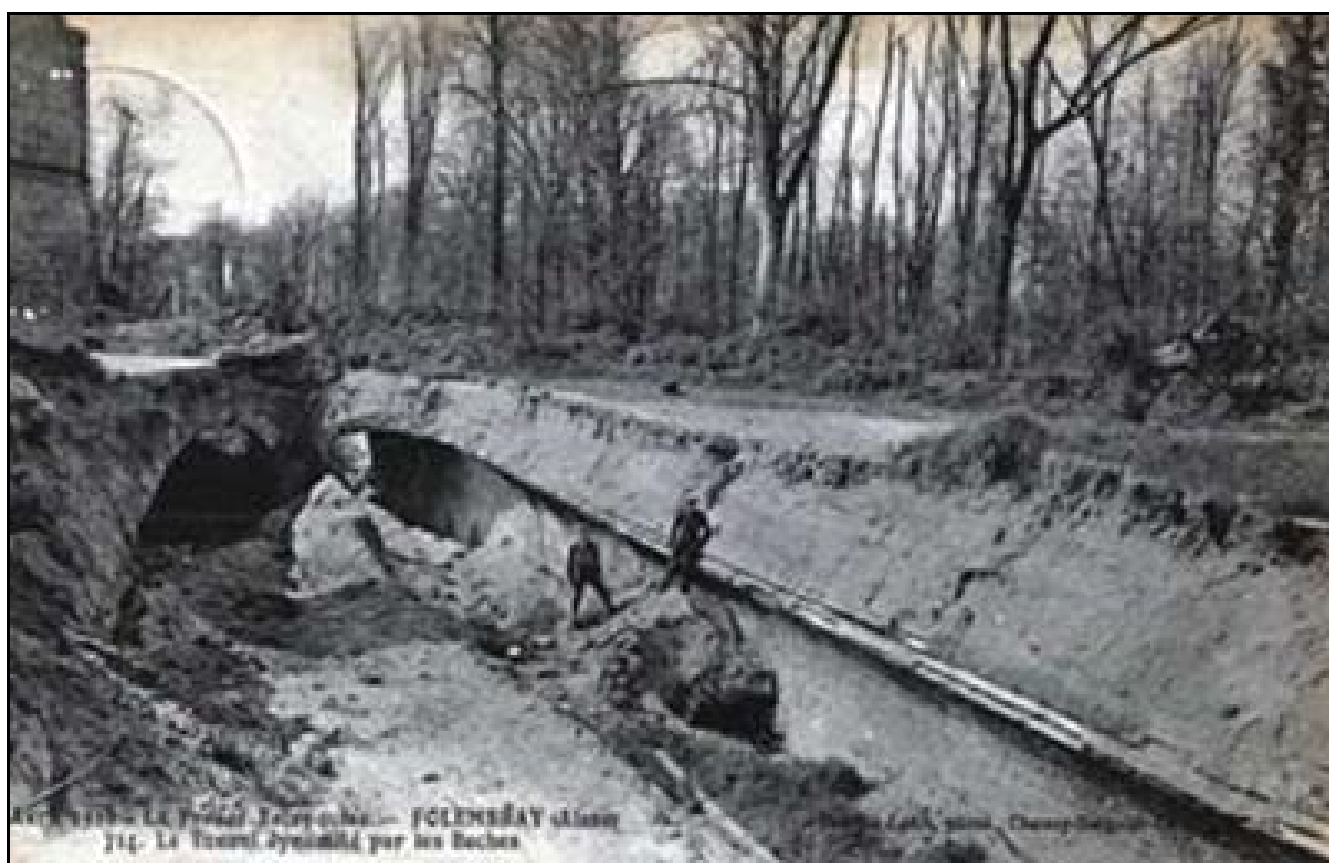
L'ensemble bitube dynamité par les Allemands juste après la guerre et avant construction du nouveau tunnel
