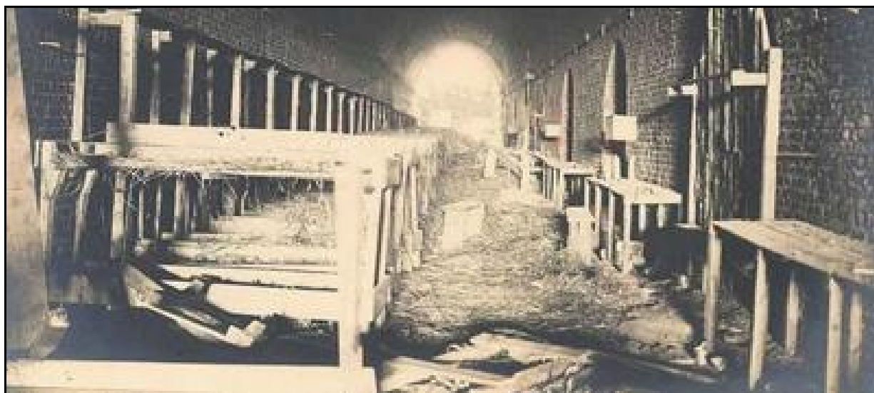
En regardant de la sortie vers l'entrée, la galerie ouest transformée en casernement souterrain Noter sur la droite la présence des niches communicantes avec la galerie est
