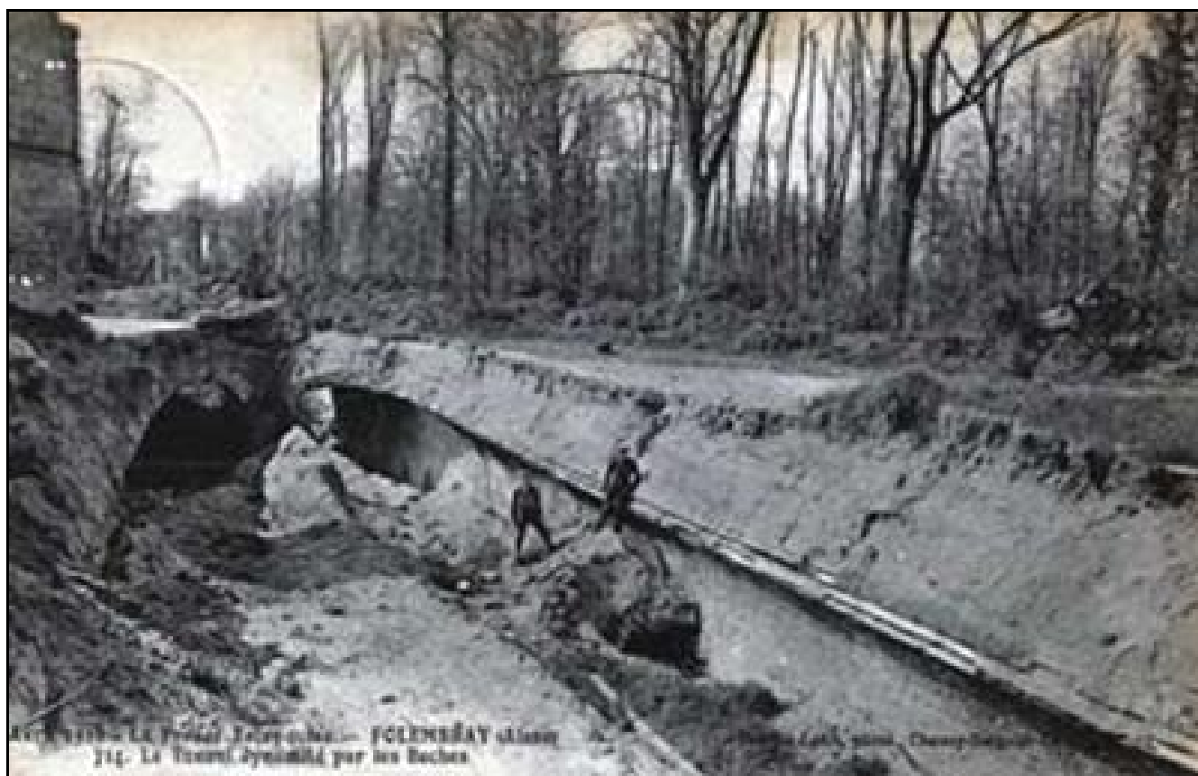
L'ensemble bitube dynamité par les Allemands juste après la guerre et avant construction du nouveau tunnel
