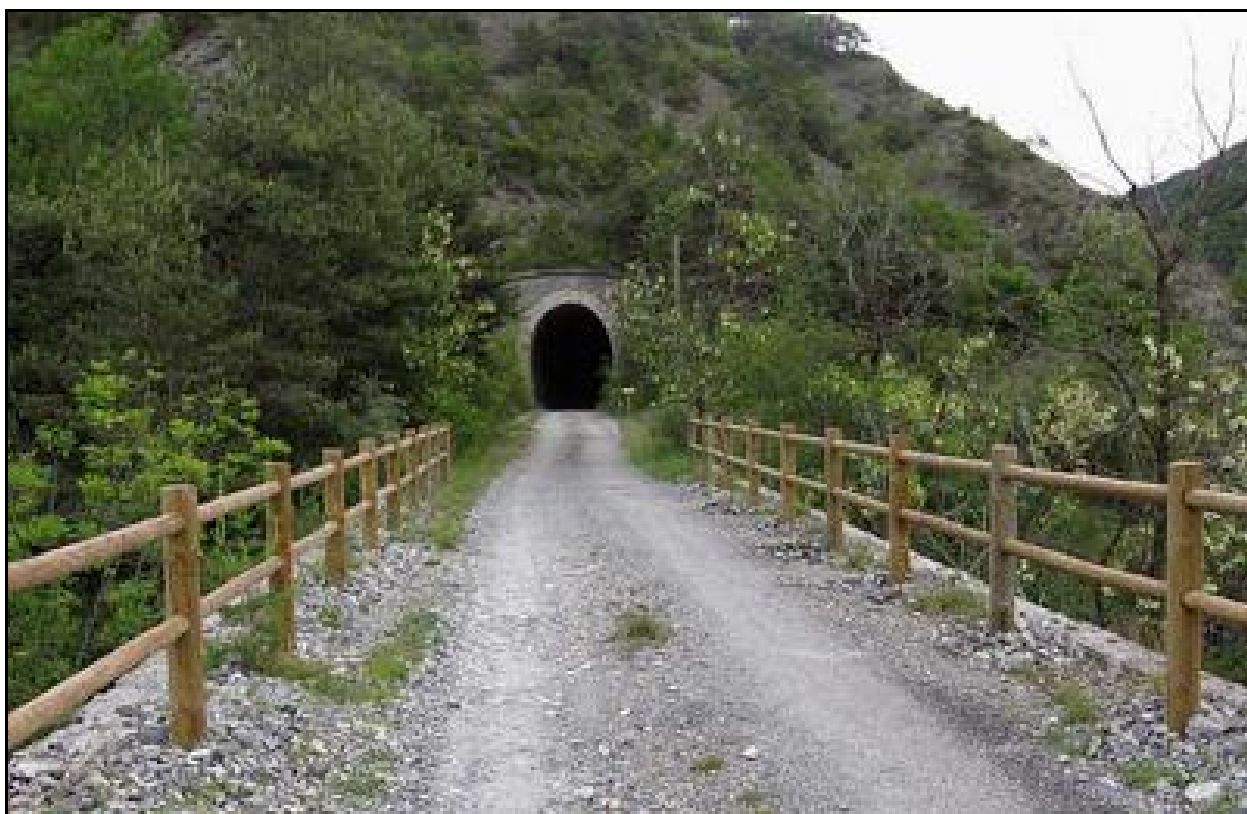
L'entrée du tunnel avec les barrières récentes installées pour le parcours de randonnée
