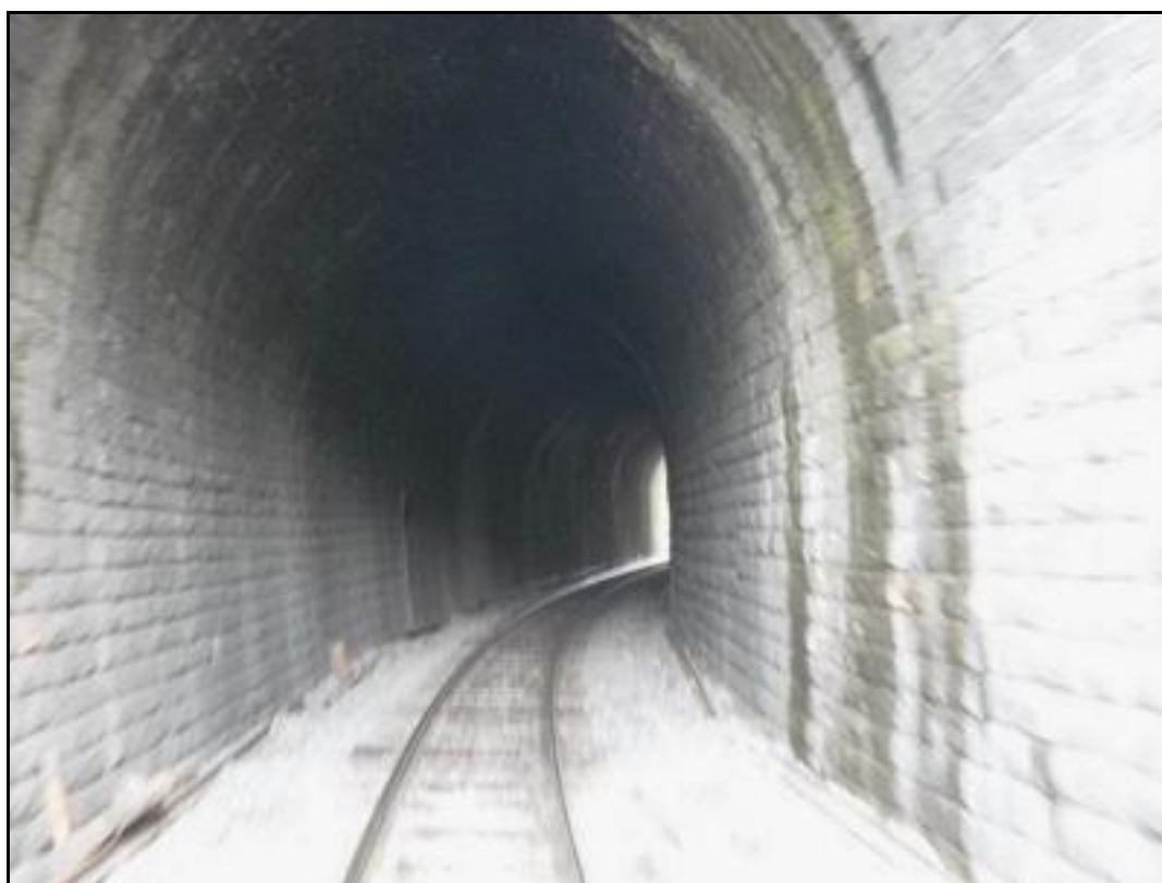
La petite galerie du tunnel du Plan de Coulomp
