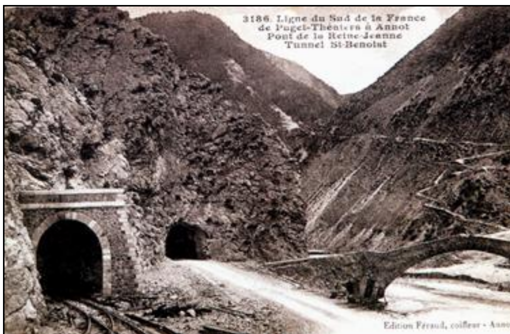
L'entrée du tunnel pendant les travaux de construction de la ligne
