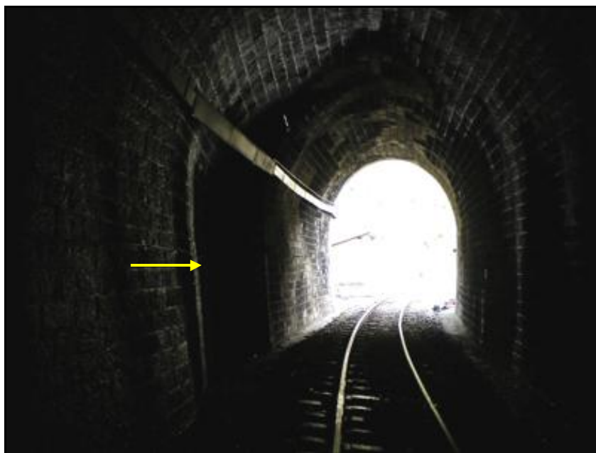
Et quelques mètres en retrait, le décrochement du piédroit gauche pour faciliter les visées d'alignement lors de la construction
