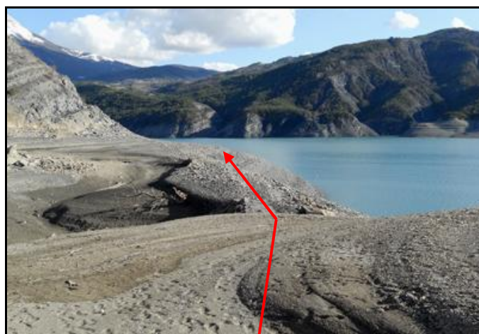
Ce qui reste de la voie ferrée vers Barcelonnette au-delà du tunnel de Sauze
