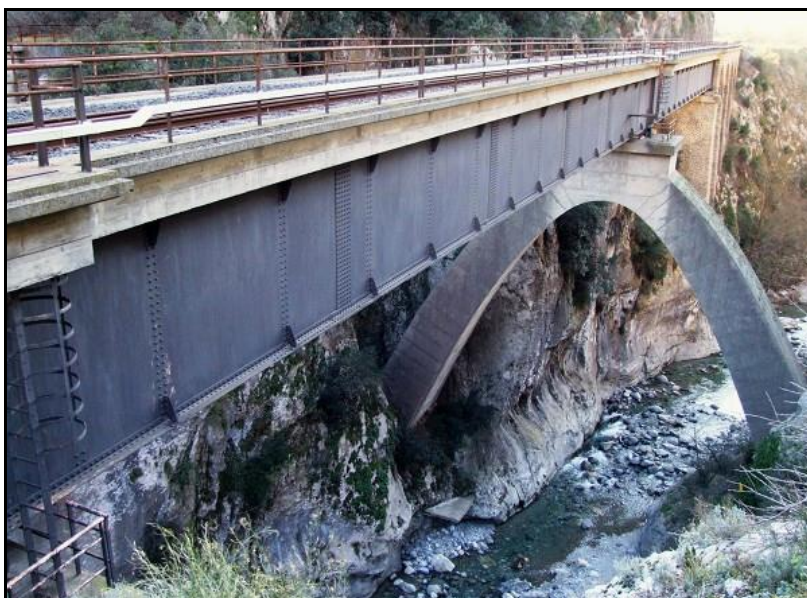
Le pont de Caï avec son arche perpendiculaire au tablier
