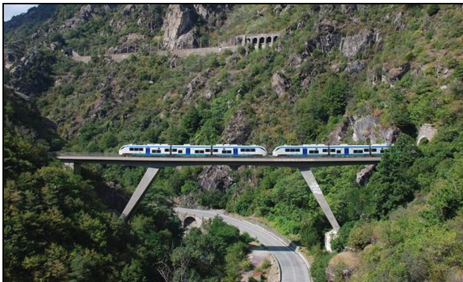
Photo montrant le viaduc de Scarassoui, l'entrée du tunnel de Bergue à droite, la sortie du tunnel du Peugeot en haut à gauche et l'entrée du tunnel de Scarassoui au-dessus du pont
