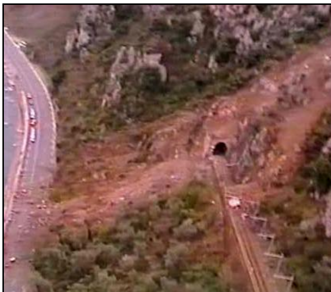
Deux vues montrant la sortie du tunnel de Gombe et l'éboulement
