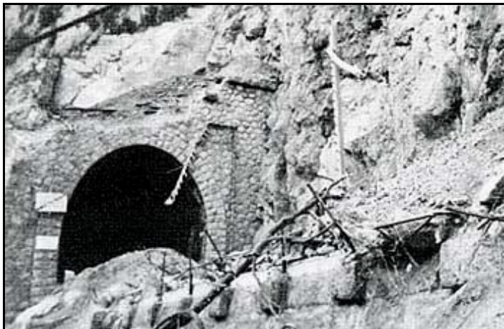
Deux vues des dégâts sur la voie
