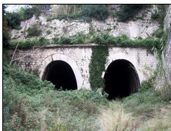
Le tunnel nord est ici à droite
