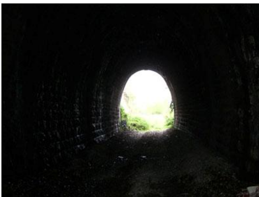
La sortie vue de l'intérieur
