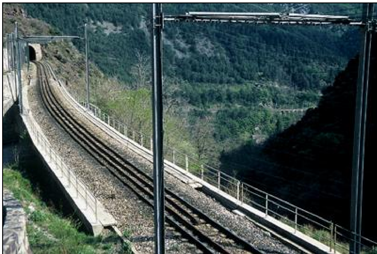
Autre vue de l'entrée du tunnel
