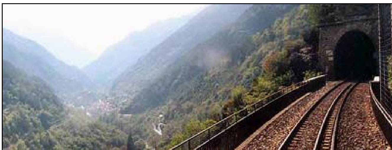
Autre vue de la sortie du tunnel
