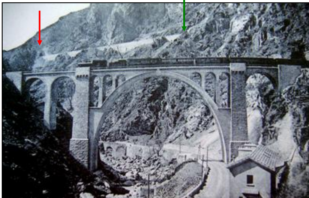
Le viaduc de Scarassoui avant guerre, du temps de la vapeur Cette photo est prise avant 1931, année d'électrification de la ligne par les Italiens A gauche, la sortie du tunnel de Peug (flèche rouge) Noter que l'entrée du tunnel de Scarassoui (flèche verte) ne possède pas de galerie de protection
