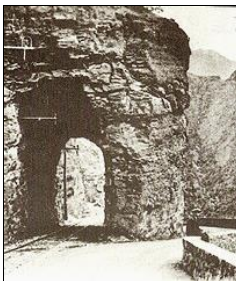
L'entrée du tunnel à l'époque du tramway
