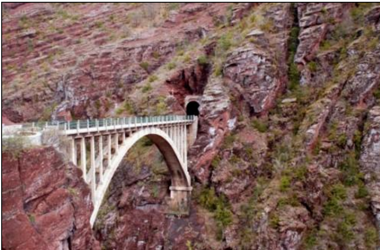
L'entrée du tunnel, juste à l'extrémité du pont de la Mariée
