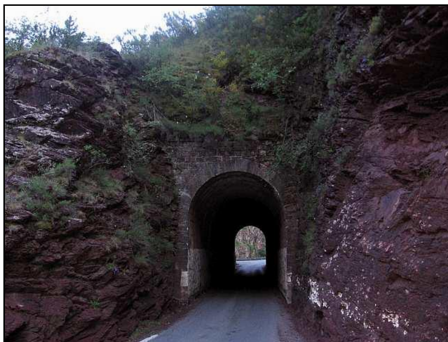
Galerie du tunnel vue depuis sa sortie
