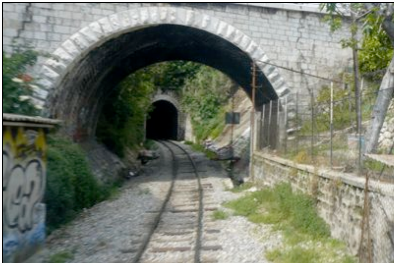
La sortie du tunnel du Piol Mantéga, côté Mantéga
