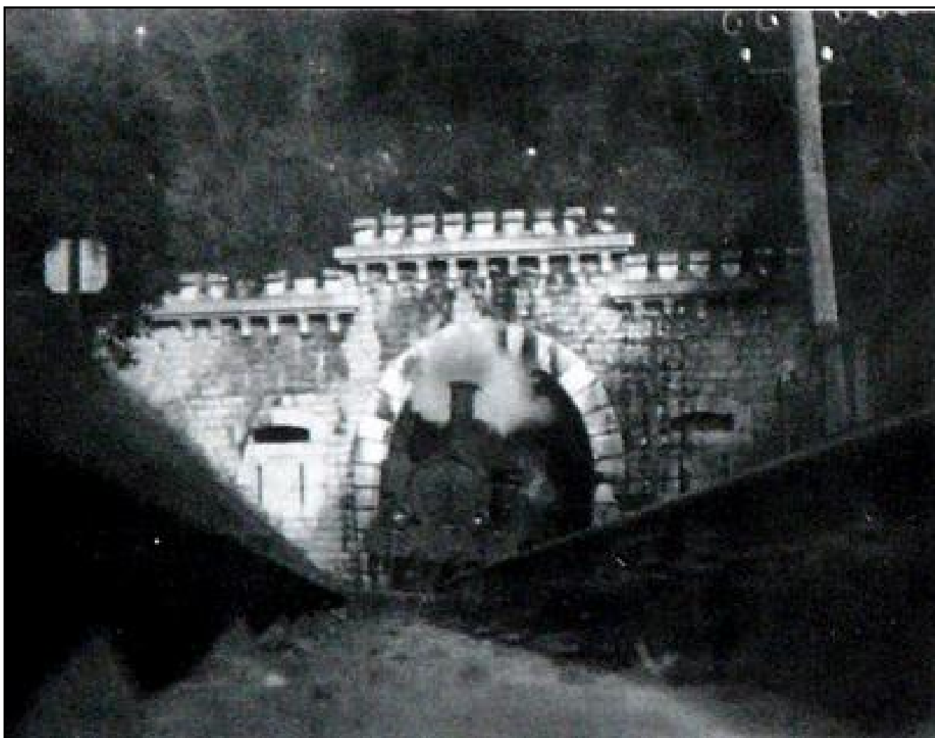
Le fronton fortifié de l'entrée du tunnel de Bellet avec sa fausse meurtrière aveugle à droite
