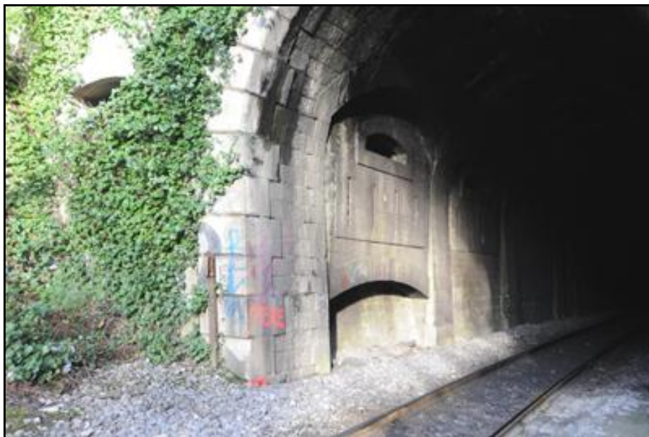
Ci-dessus et ci-dessous, détail de la fortification dans l'entrée de la galerie Les fentes verticales sont des goulottes pour laisser tomber des grenades
