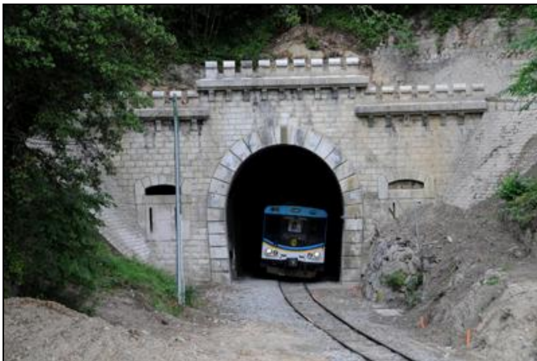
Ci-dessus et ci-dessous, l'entrée du tunnel hier et aujourd'hui A noter le gabarit large du tunnel initialement prévu pour recevoir une voie normale
