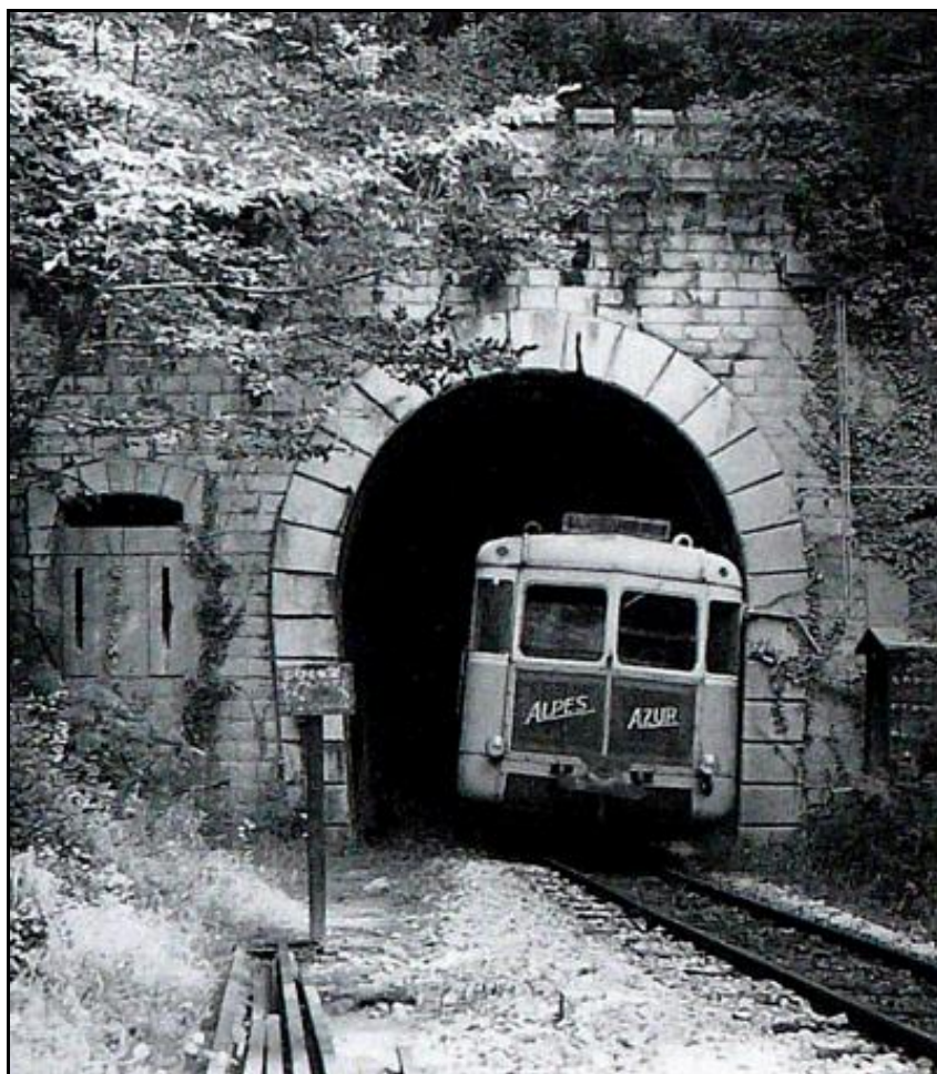
Ci-dessus et ci-dessous, l'entrée du tunnel hier et aujourd'hui A noter le gabarit large du tunnel initialement prévu pour recevoir une voie normale
