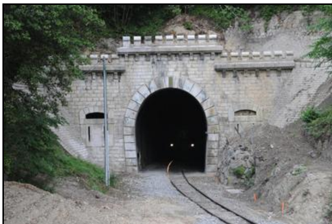
L'entrée dans son état actuel après réfection
