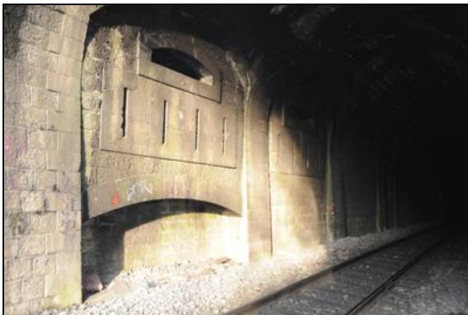
Ci-dessus et ci-dessous, détail de la fortification dans l'entrée de la galerie Les fentes verticales sont des goulottes pour laisser tomber des grenades
