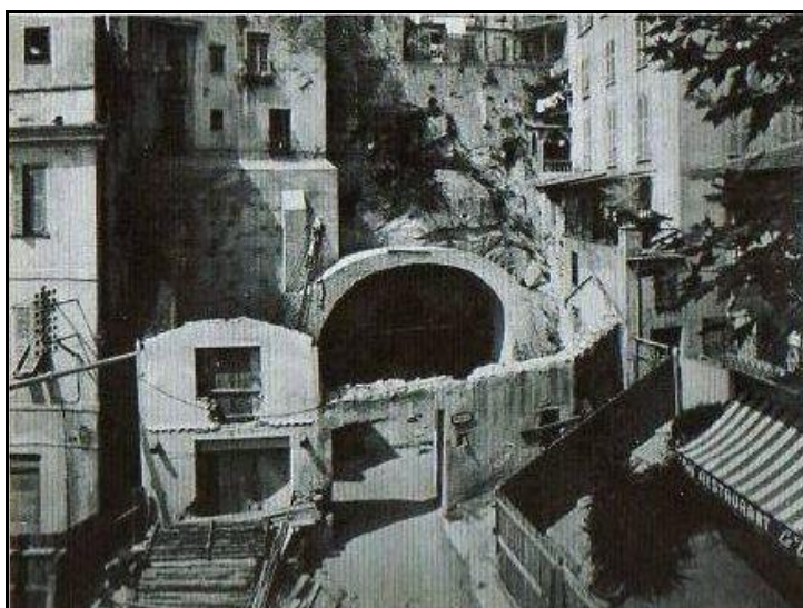
La sortie du tunnel de Sainte Dévôte
