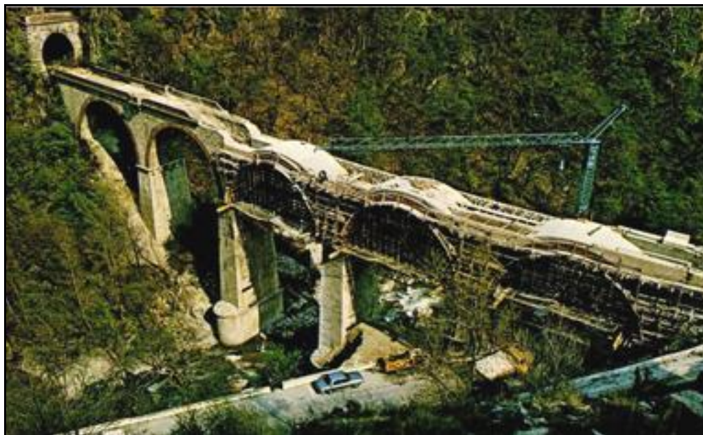
L'entrée du tunnel de Saint Roch qui fait suite au viaduc de l'usine en reconstruction suite à son dynamitage pendant la dernière guerre
