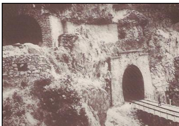
La galerie de protection et ses 4 fenêtres lors de la reconstruction reliant les deux vrais tunnels de Saint Roch Notez le caniveau d'écoulement d'eau dont on voit l'amorce au-dessus de la galerie et la sortie en-dessous de la deuxième fenêtre
