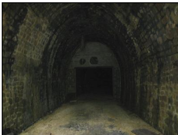
Les cloisons internes des sas situés aux extrémités du tunnel
