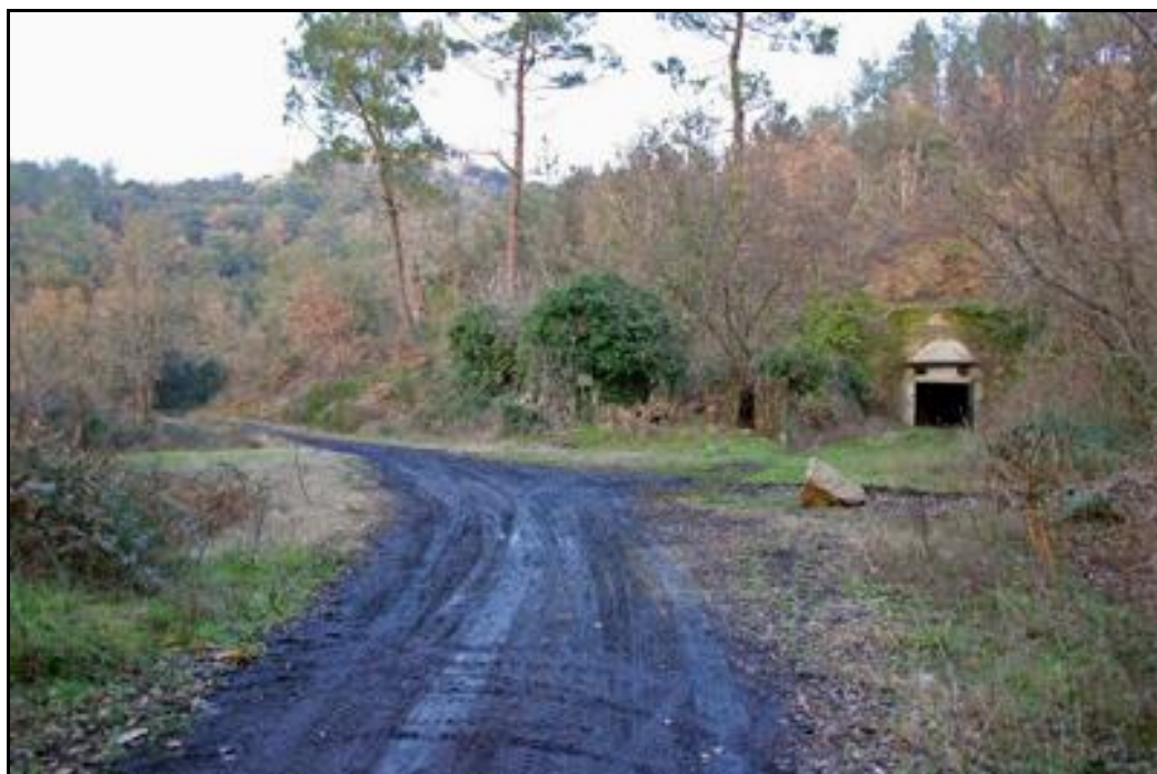
La sortie du tunnel prise depuis l'emplacement de l'ancienne gare de transbordement du chemin de fer minier des mines de Banne (à gauche)
