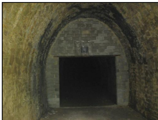
Les cloisons internes des sas situés aux extrémités du tunnel
