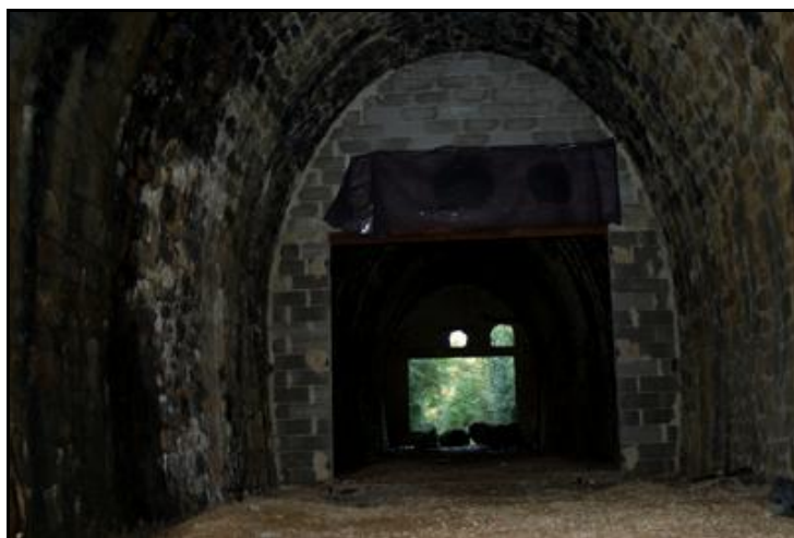
L'entrée du tunnel vue depuis l'intérieur à travers la porte du sas interne
