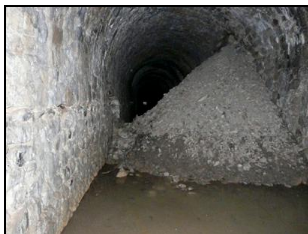
Ci-dessus et ci-dessous, trois aspects de la galerie dont un piédroit est effondré Les rails visibles sur la photo ci-dessous correspondent à une petite voie Decauville datant de l'exploitation de la champignonnière
