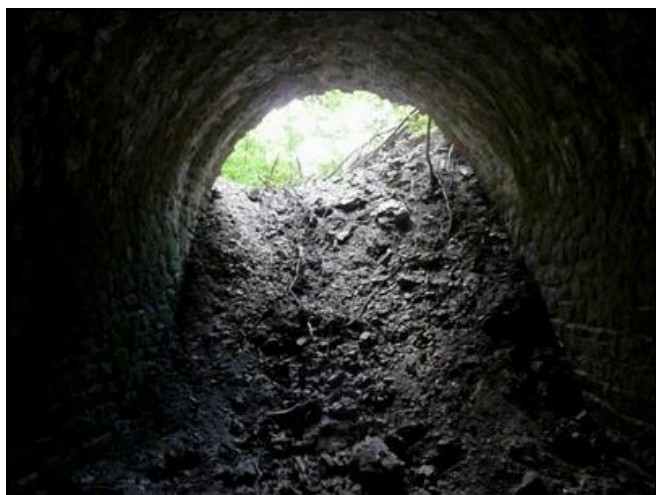
L'entrée vue de l'intérieur de la galerie
