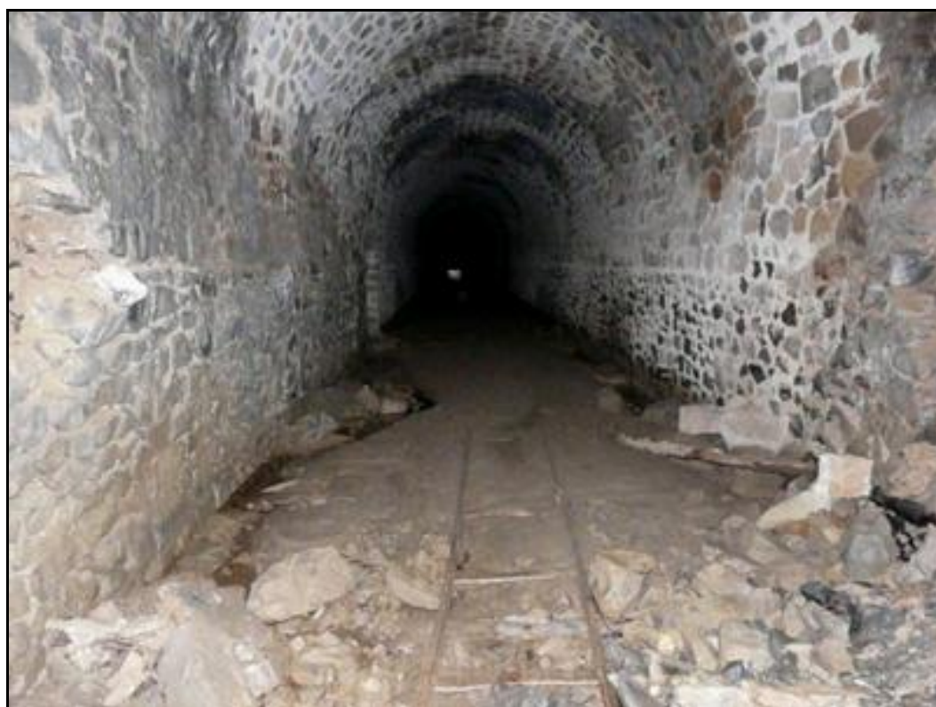
Ci-dessus et ci-dessous, trois aspects de la galerie dont un piédroit est effondré Les rails visibles sur la photo ci-dessous correspondent à une petite voie Decauville datant de l'exploitation de la champignonnière
