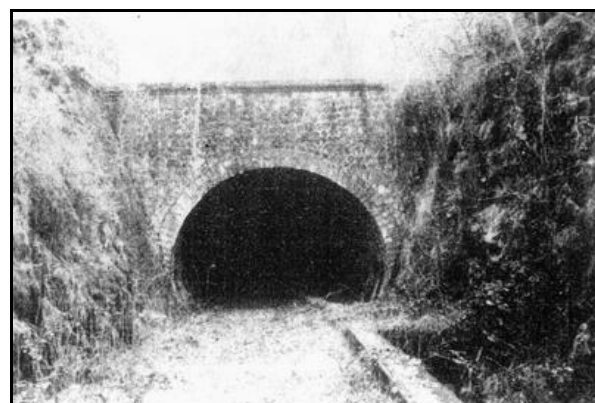
La sortie, peu de temps après l'abandon de la ligne et le drain latéral particulièrement important
