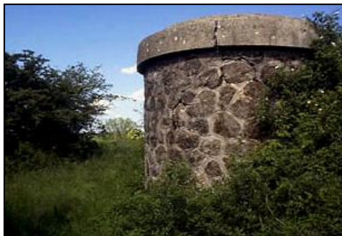
Le débouché extérieur de la cheminée d'aération
