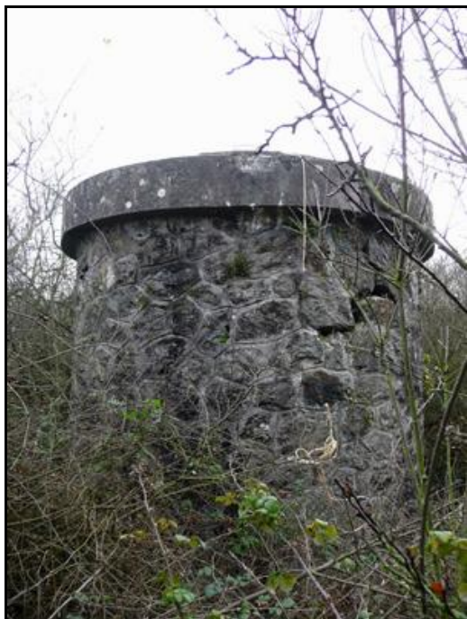
Le débouché extérieur de la cheminée d'aération
