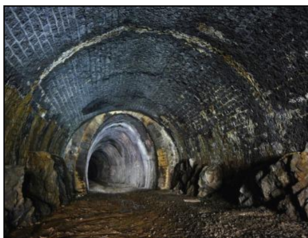
Côté entrée, la galerie laisse clairement apparaître le fronton initial du tunnel, précédé par une section en tranchée couverte
