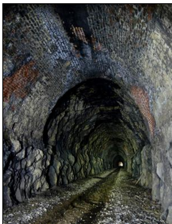
Le tunnel primitif en voie unique
