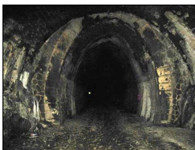
Côté entrée, la galerie laisse clairement apparaître le fronton initial du tunnel, précédé par une section en tranchée couverte
