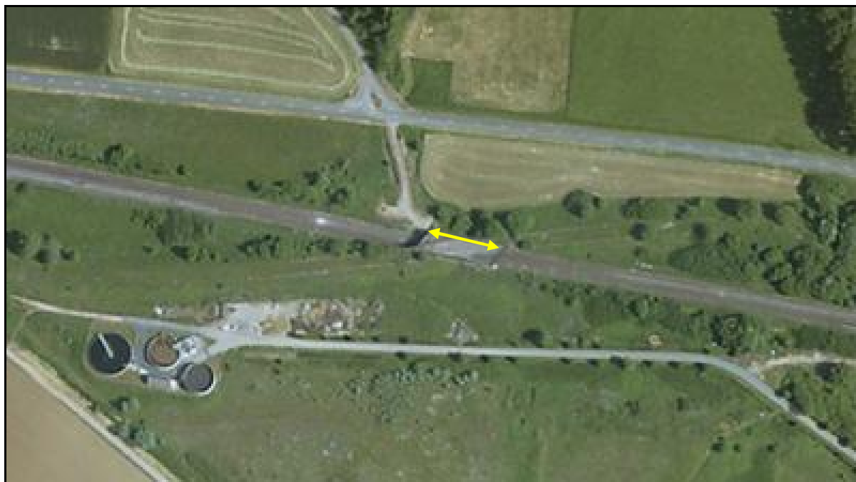
Vue aérienne du saut de mouton Les voies supérieures ont été retirées
