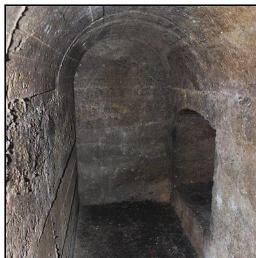
Ci-dessus et ci-dessous, accès aux fourneaux de mine
