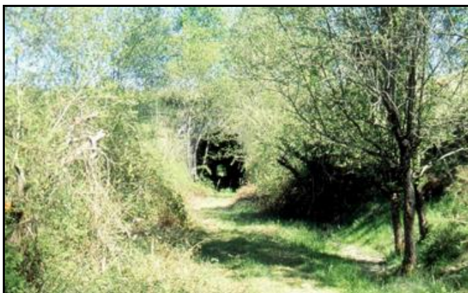
L'entrée du tunnel abandonné avant aménagement de la Voie Verte
