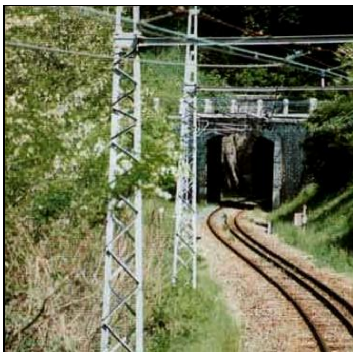
La sortie du tunnel en partie cachée par le pont de l'ancienne RN 20 Notez la présence d'un rail central destiné à rigidifier la voie
