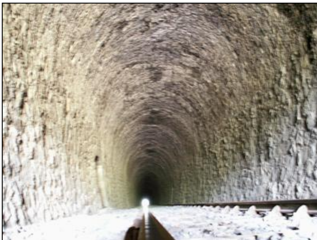
La galerie du tunnel prise au niveau du rail
