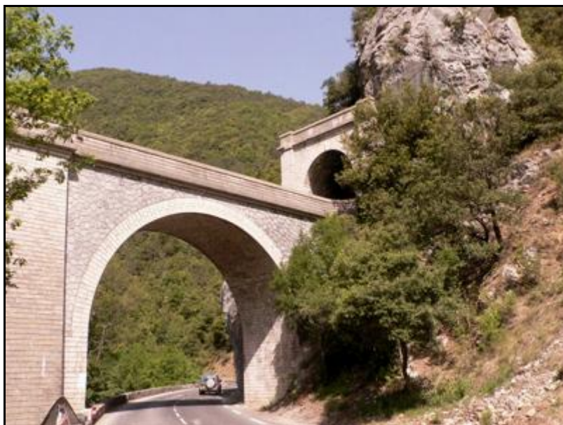
La sortie du tunnel de Rebuzo et le viaduc qui lui fait suite A noter que ce viaduc a des piles creuses dans lesquelles on peut descendre et qui servent de chambres de démolition
