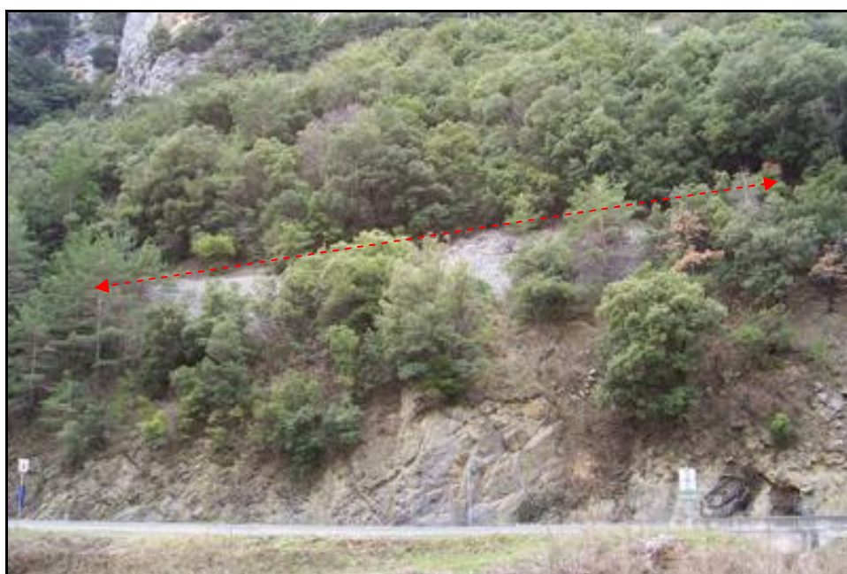
Vu de l'extérieur, on devine la maçonnerie de la galerie de protection à travers le végétation
