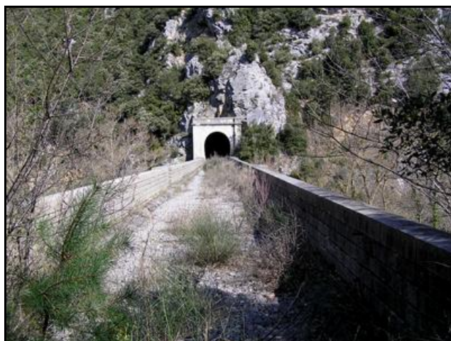
La sortie du tunnel de Rebuzo et le viaduc qui lui fait suite A noter que ce viaduc a des piles creuses dans lesquelles on peut descendre et qui servent de chambres de démolition
