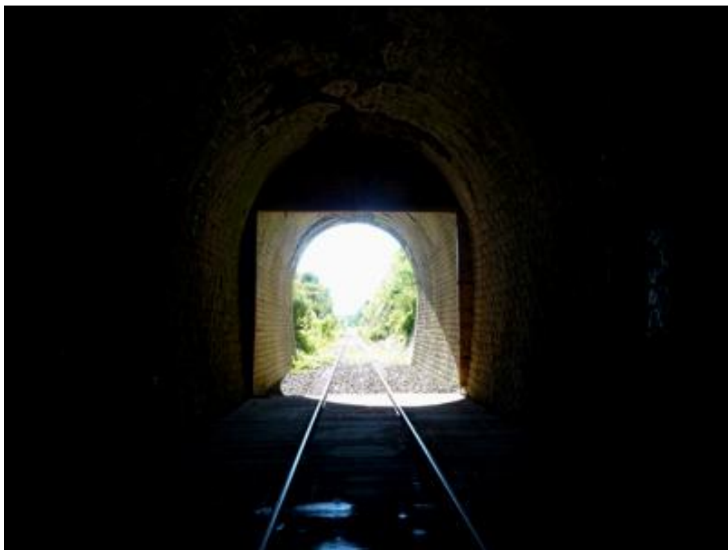
La sortie vue de l'intérieur, à travers l'ouverture de la cloison en bois
