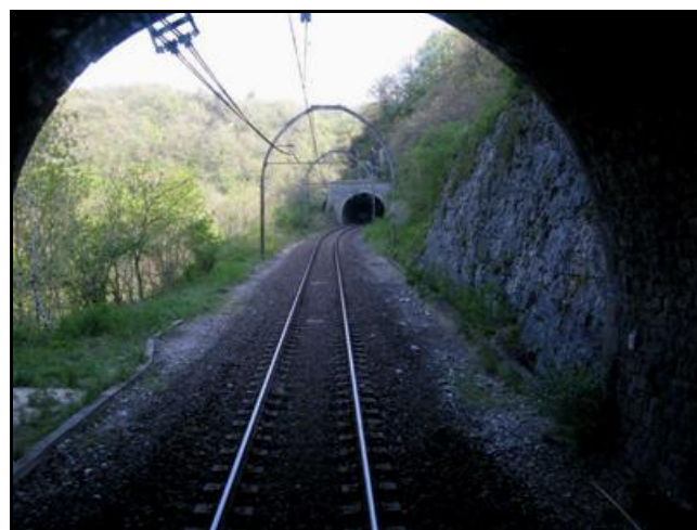
Ci-contre, la sortie du tunnel de la Grotte et, au fond, l'entrée du tunnel de Gaudolet
