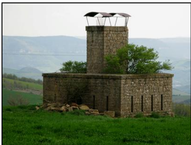
Débouché extérieur de l'une des deux cheminées d'aération du tunnel
