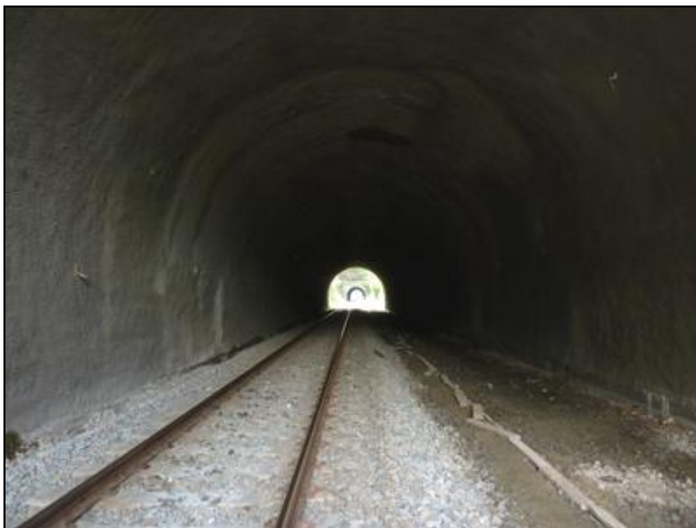
La galerie du tunnel, en regardant vers sa sortie Au fond, l'entrée du tunnel de Clavel
