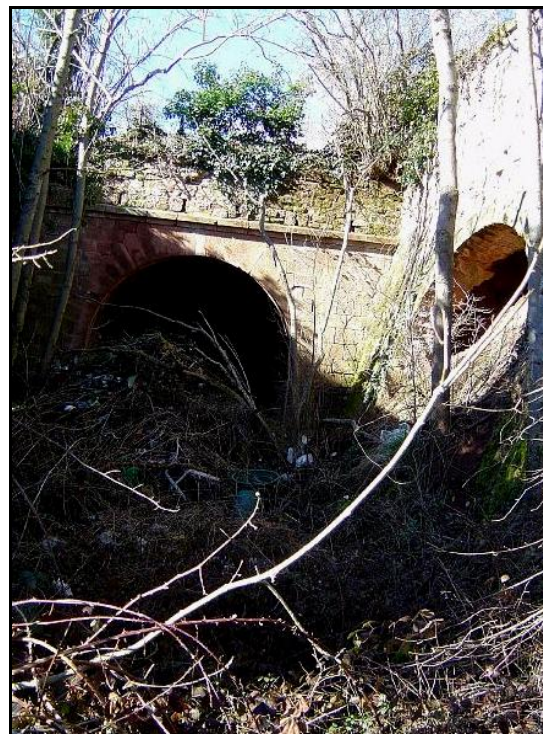
Ci-dessus et ci-dessous, le souterrain et sa sortie dans son état antérieur : galerie inondée et sortie servant de décharge sauvage
