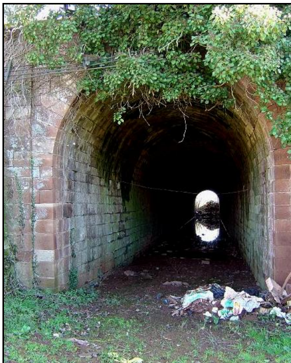
Ci-dessus et ci-dessous, le souterrain et sa sortie dans son état antérieur : galerie inondée et sortie servant de décharge sauvage
