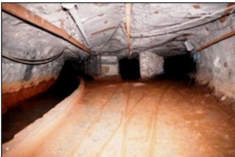
Au centre, le départ de la galerie de la Mer A gauche, un petit canal destiné à la récupération des eaux d'infiltration A droite, une galerie de mine
