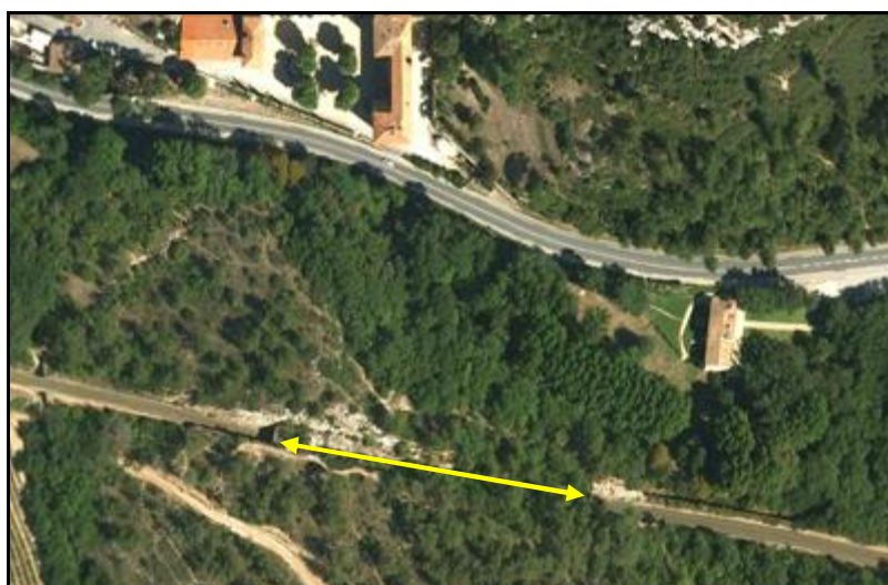
Vue aérienne de la tranchée couverte
