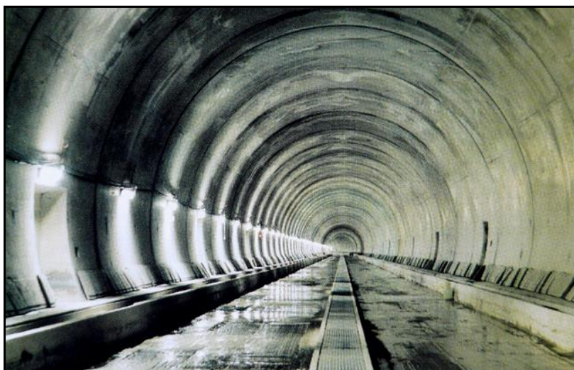
La galerie terminée, avant pose des voies
