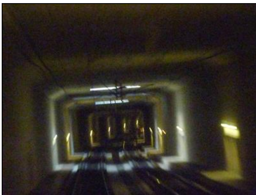
Dans la tranchée couverte de liaison entre les deux vrais tunnels, deux regards d'aération vers l'extérieur
