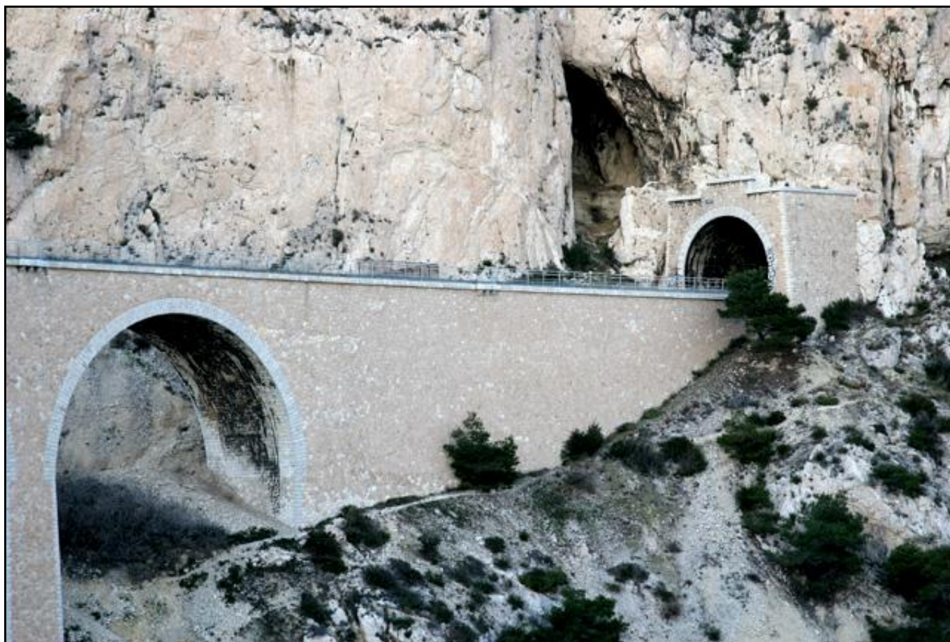
La queue du viaduc de la Vesse et l'entrée du tunnel
