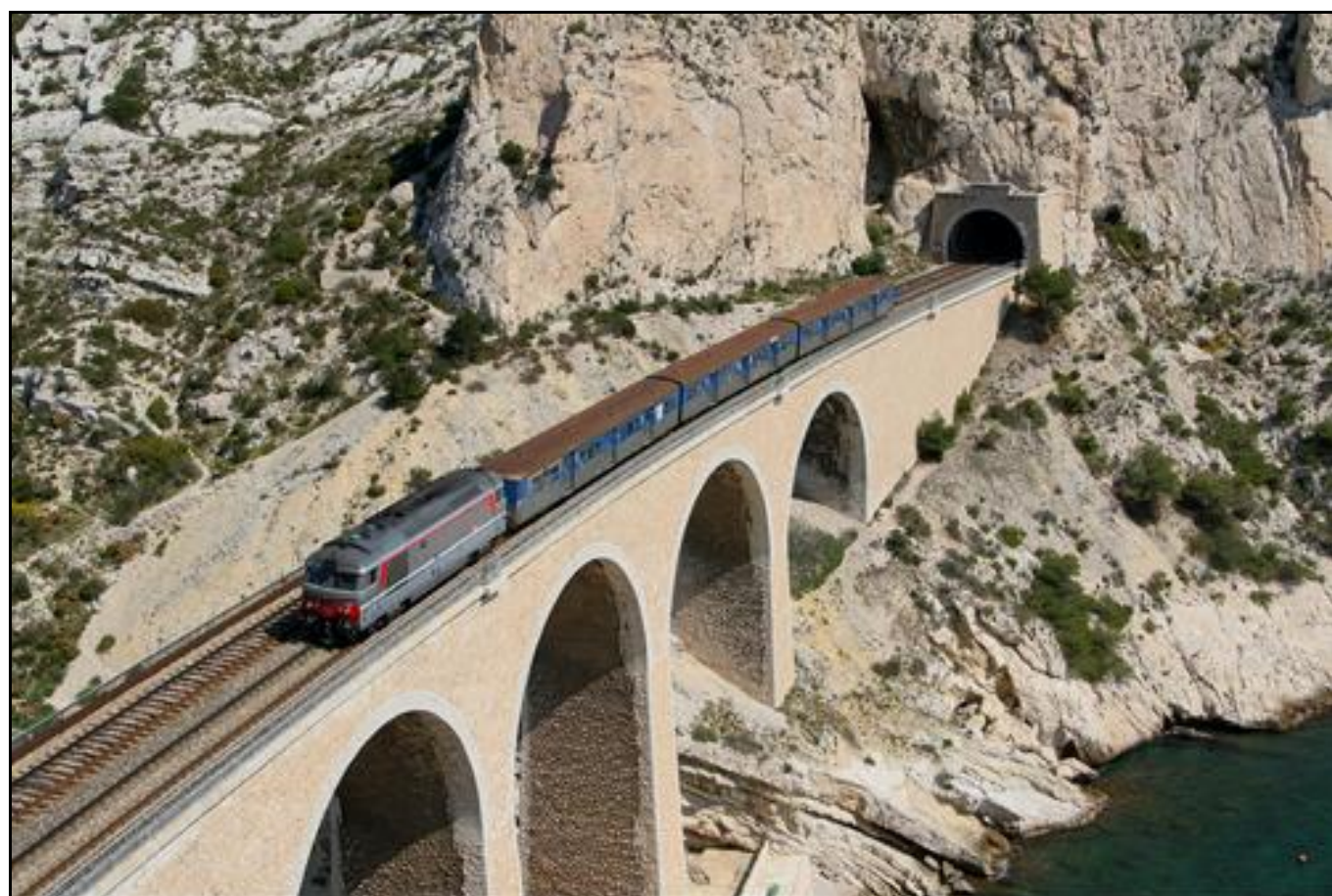
Ci-dessus et ci-dessous, trois superbes vues de l'entrée du tunnel qui fait suite au viaduc de la Vesse
