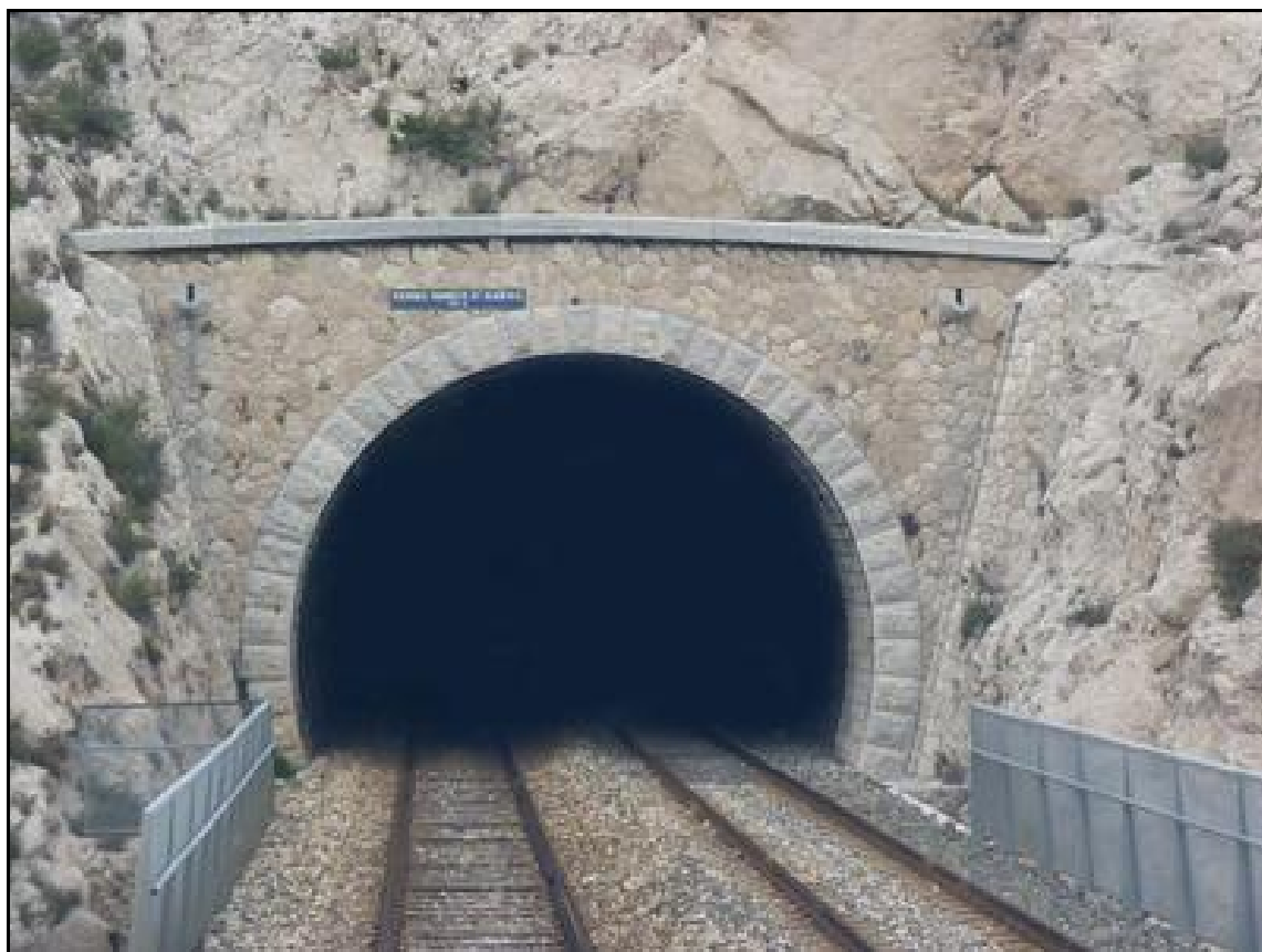
L'entrée du tunnel
