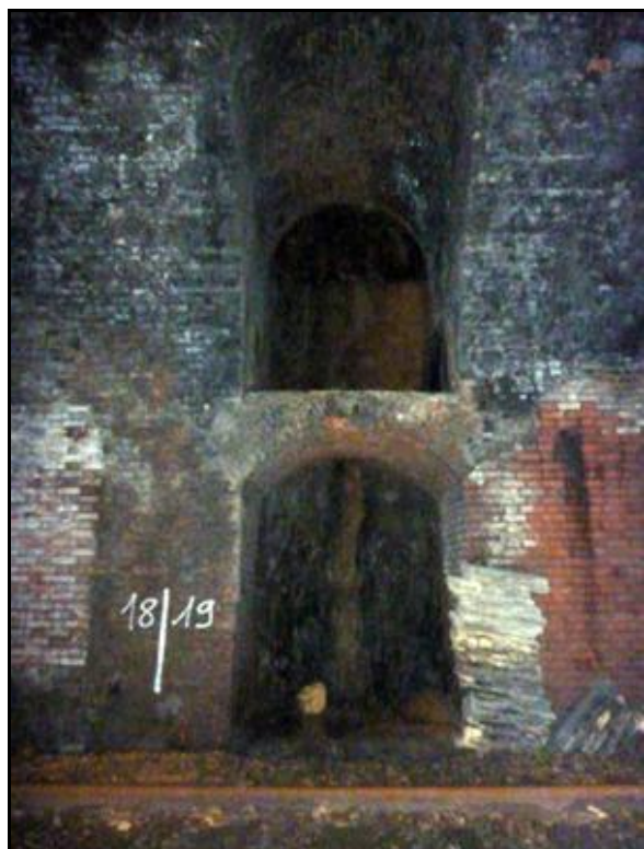
Ci-dessus et ci-dessous, débouchés des deux cheminées d'aération dans la galerie Chaque cheminée débouche par deux orifices : une niche inférieure et un orifice supérieur situé à la naissance de la voûte
