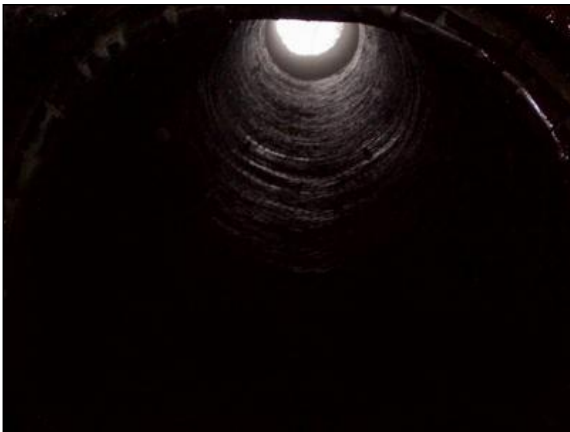
L'une des cheminées d'aération vue depuis le souterrain
