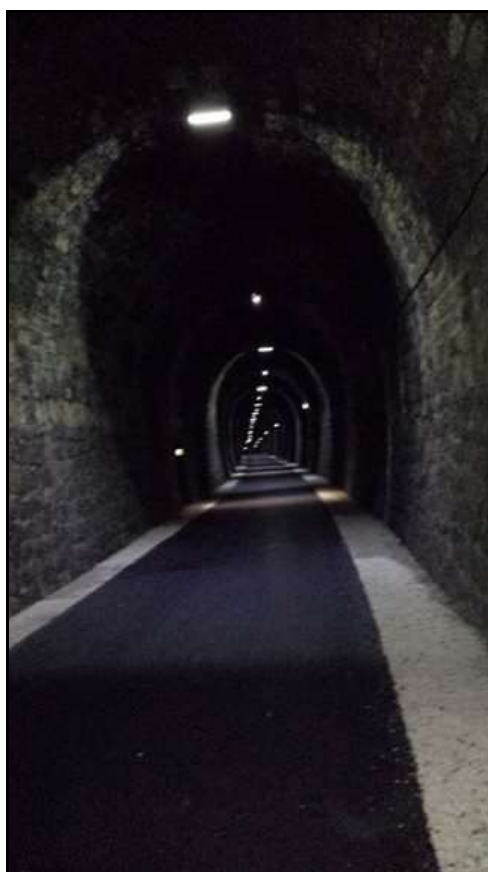
La galerie aménagée depuis 2012, avec éclairage
