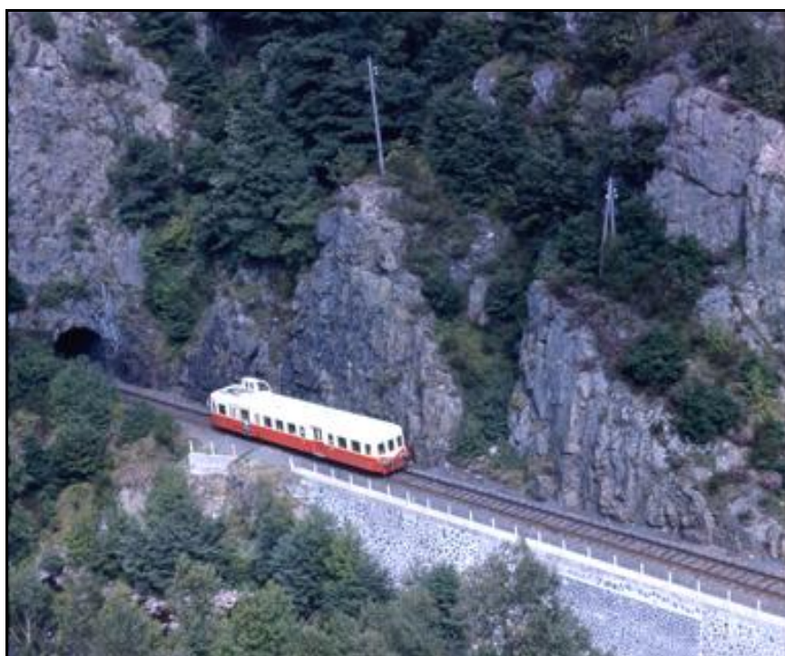
La sortie du tunnel avant que la voie ne soit protégée contre les chutes de pierres
