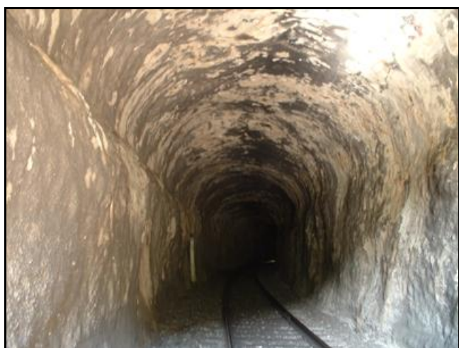
La galerie taillée directement dans la roche, sans parement maçonné, et sa sortie
