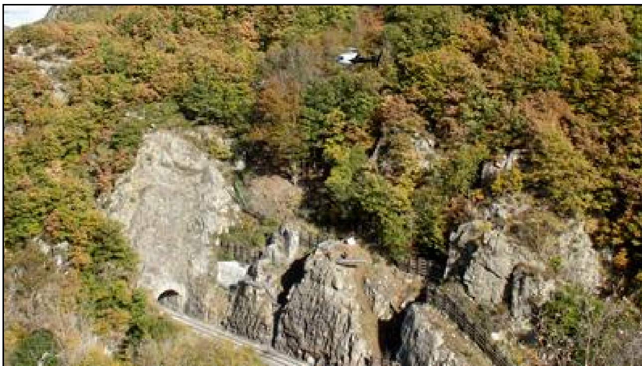
Mise en place des installations de protection par hélicoptère
