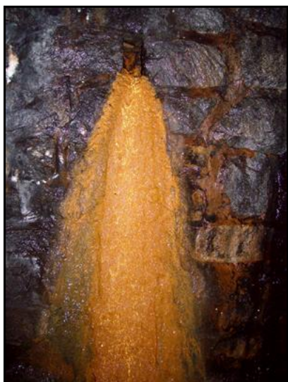
Dans la galerie, une belle source ferrugineuse et un drain de captage mural
