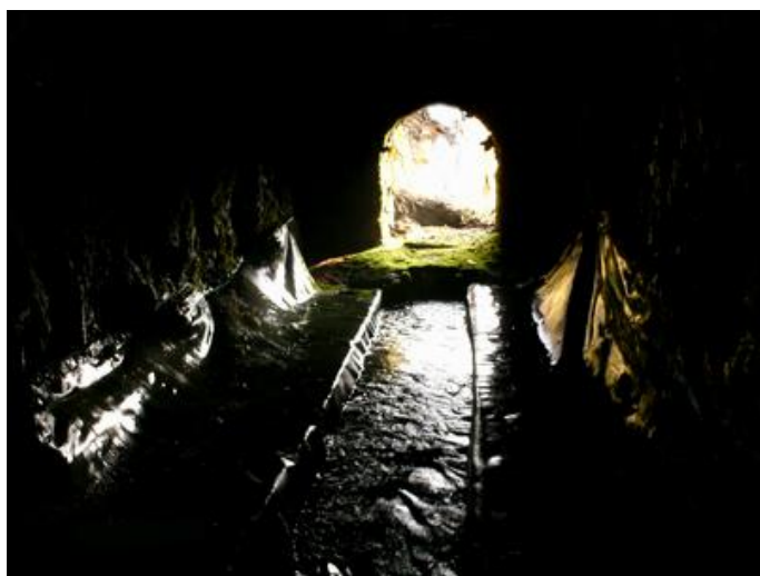
L'intérieur du drain qui montre bien l'important volume des eaux d'infiltration
