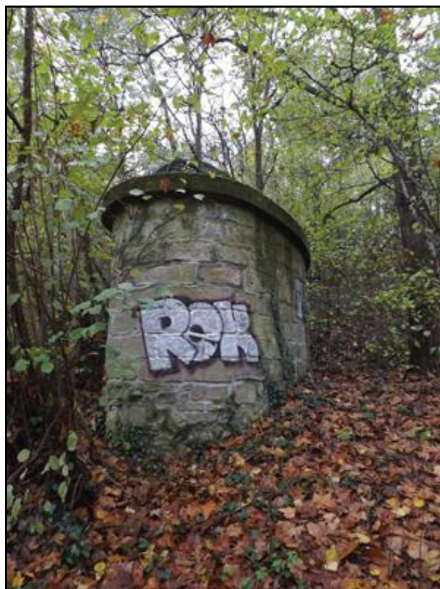
Ci-dessus et ci-après, le débouché de la cheminée d'aération, au sommet de la colline
